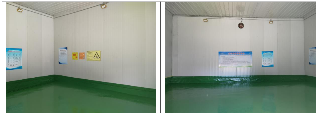
图 3-6 废脱硝催化剂暂存间
