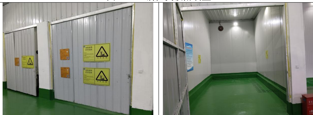
图 3-5 其他危废暂存间（泄漏液和废塑料桶）
