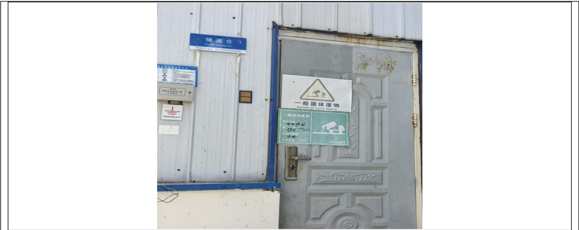
图3-11 一般固废暂存间（储泥仓）
