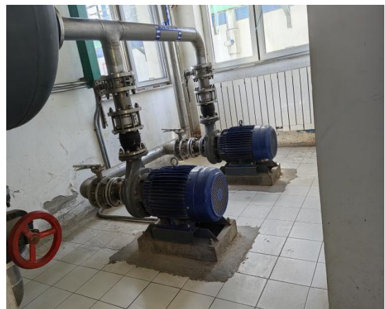
图3-10 气浮循环泵基础减振
