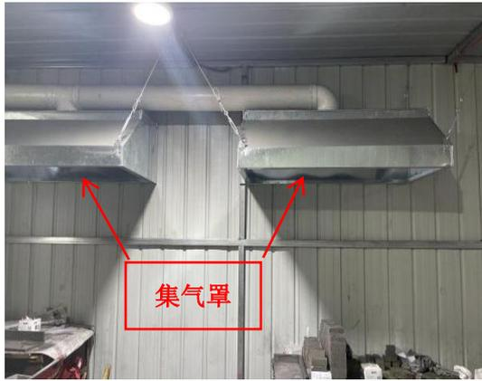
图 3-4 粘板废气集气罩 (2 个)
