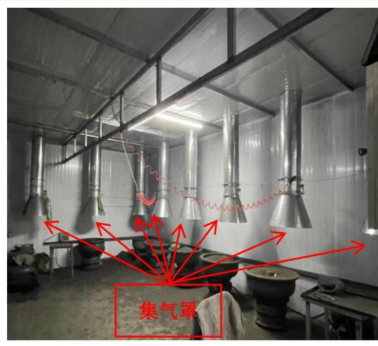
图 3-7 蜗牛倒角废气集气罩 (8 个)
