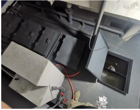
图 3-3 污水处理站隐蔽工程现场施工图
