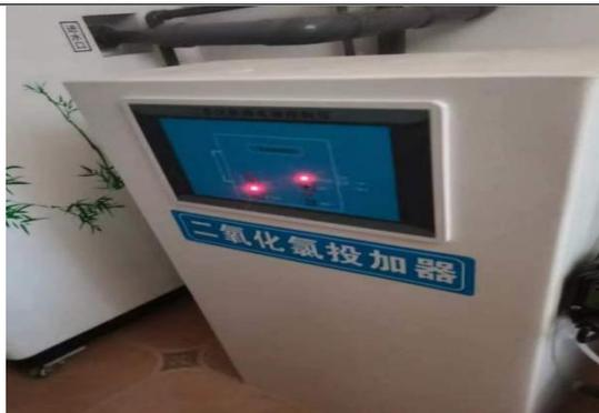
图 3-5 污水处理站二氧化氯投加器
