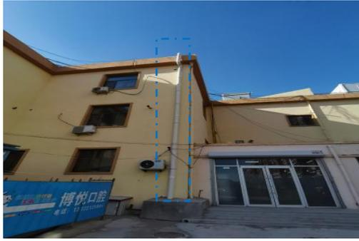
图 3-7 污水处理站废气排气筒（15m 高）
