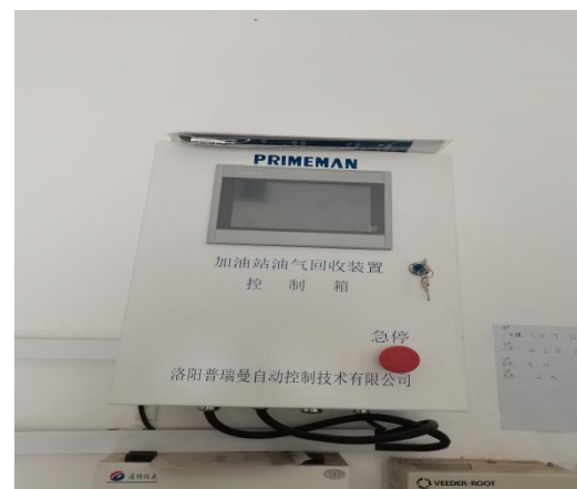
图 3-10 油气回收装置控制箱
