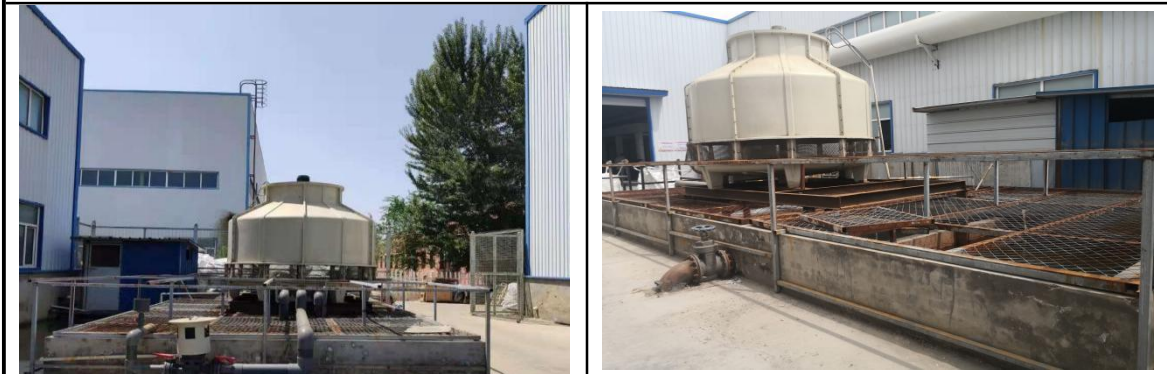
图 4-10 电解炉冷却循环水系统（自来水）
