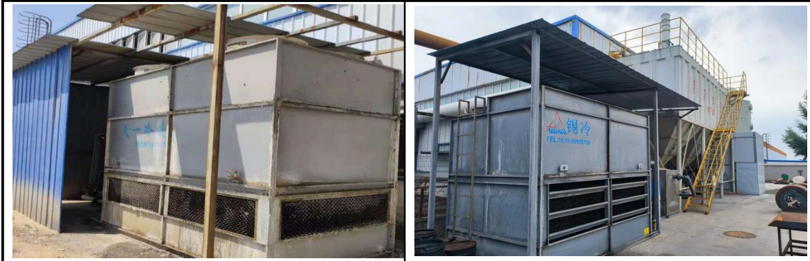
图 4-9 整流柜等冷却循环水系统（纯水）
