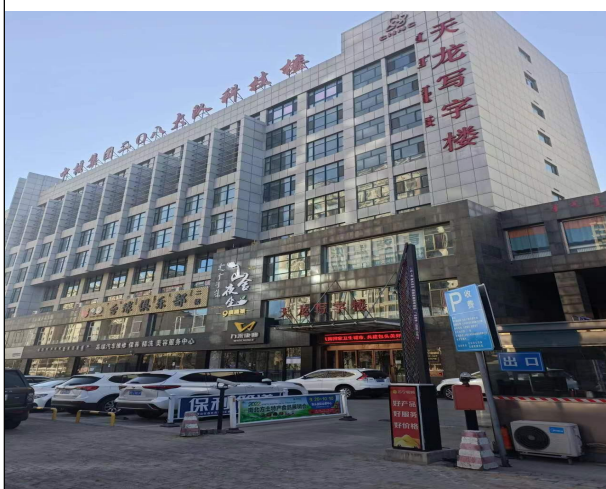
西侧：天龙写字楼
