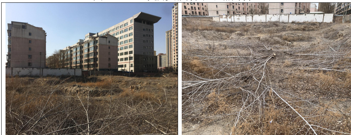
图3.4-5 地块建筑物拆除后影像图
