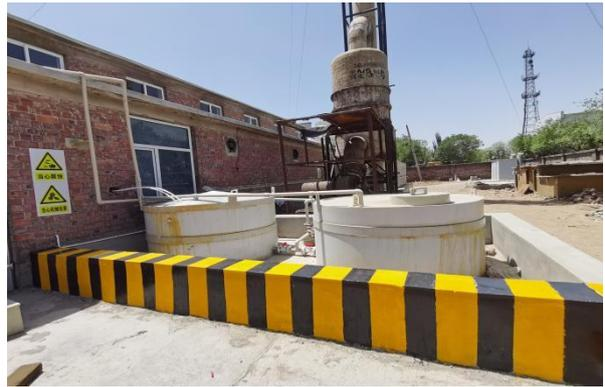
图 4-2 氢氟酸罐及围堰
