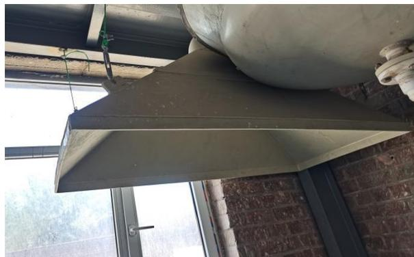
图 4-6 抛光粉前驱体生产搅拌集气罩
