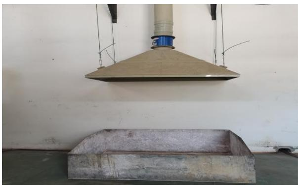
图 4-5 氟化炉生产搅拌集气罩
