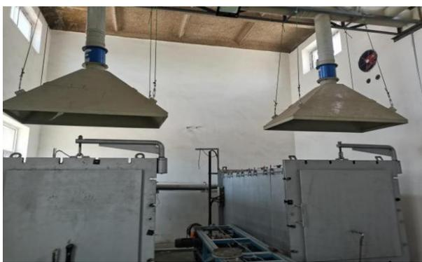
图 4-3 氟化炉生产上部集气罩
