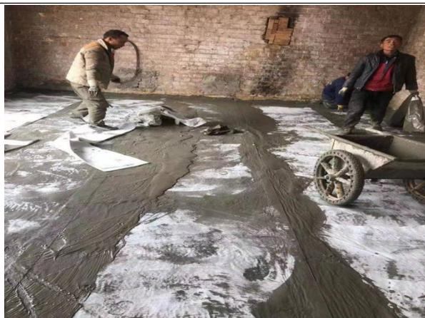
图 4-17 生产车间防渗施工图片
