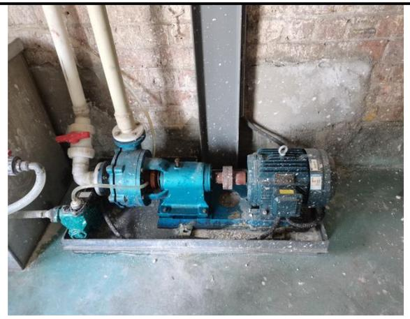
图 4-10 设备减振基础
