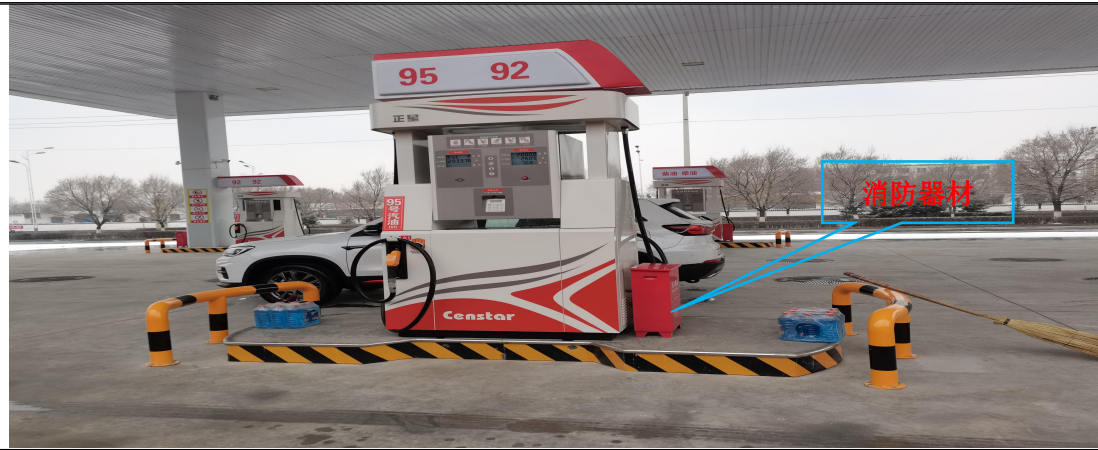
图 3-12 加油区消防设施
