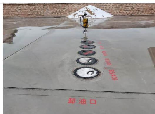
图 3-2 地埋式卸油口
