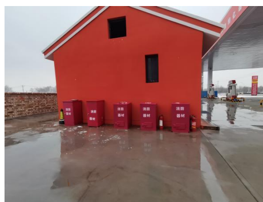
图 3-11 卸油区消防设施
