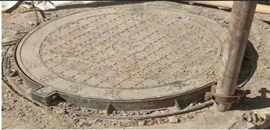
图 3-14 地下水监测井
