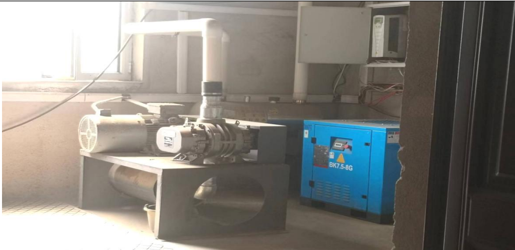
图 4-12 设备减振基座
