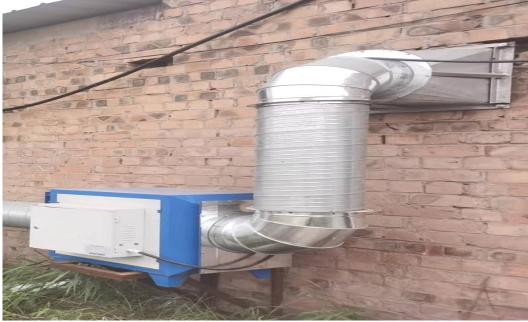
图 4-11 油烟净化装置
