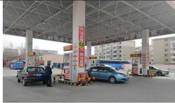
图 3-10 加油区消防设施
