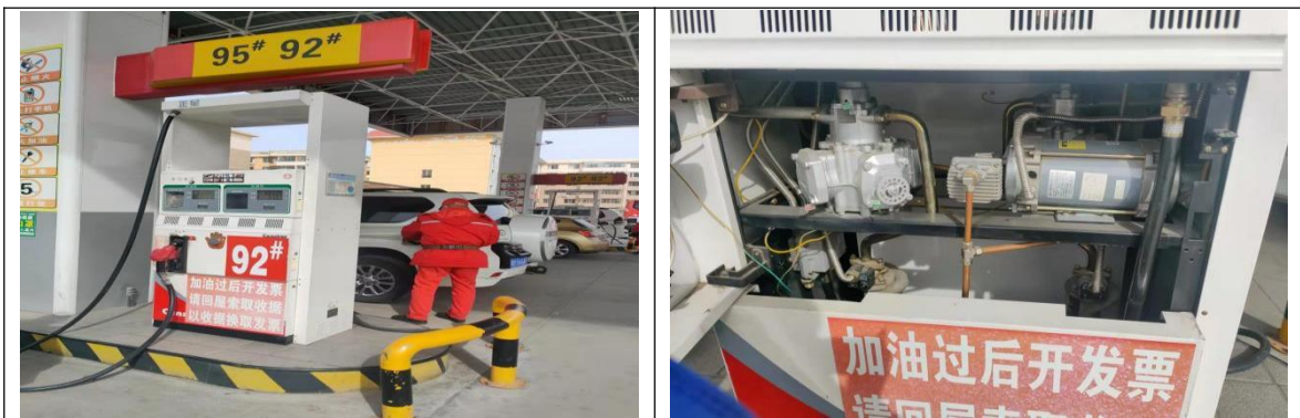
图 3-3 加油机（油气回收装置）
