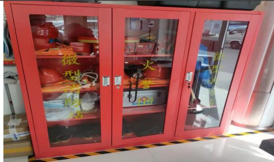
图 3-9 站房消防设施
