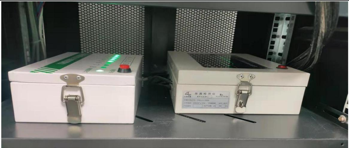
图 3-6 泄漏检测仪
