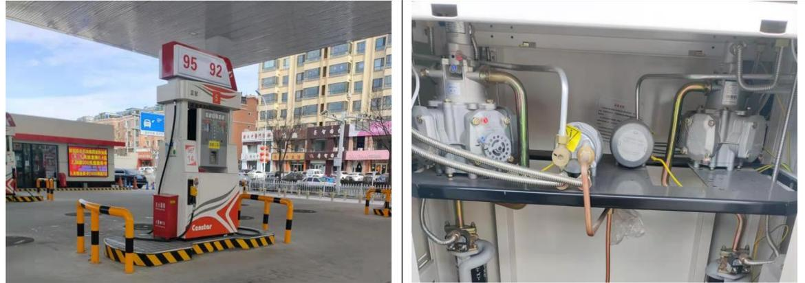
图 3-1 加油机（油气回收装置）
