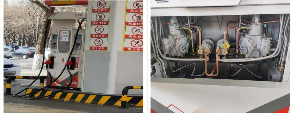
图 3-2 加油机（油气回收装置）
