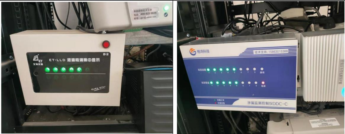
图 3-6 泄漏检测仪
