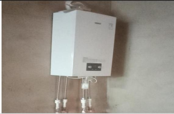
图 3-9 燃气壁挂炉
