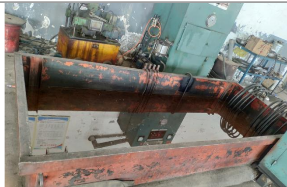
图 3-2 试压设备循环水池
