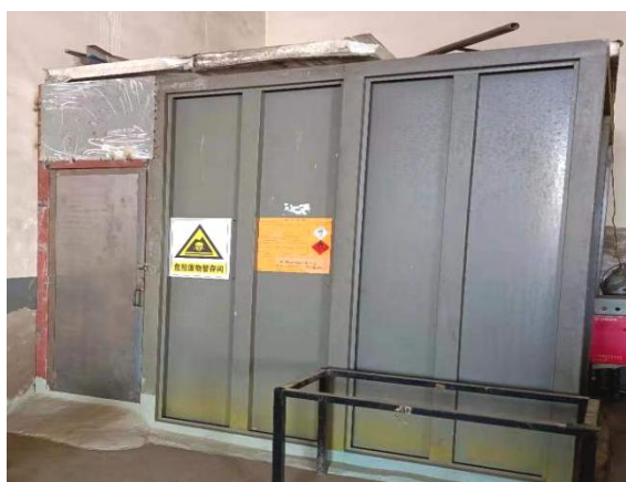
图 3-7 危险废物暂存间
