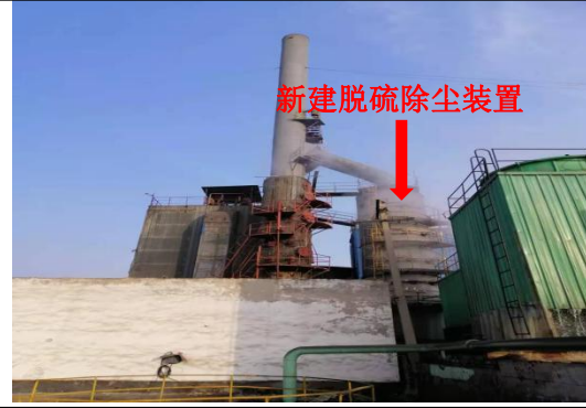
图 3-8 脱硫装置
