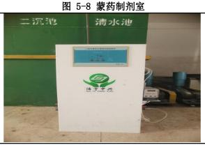
图 5-10 污水处理站二氧化氯发生器
