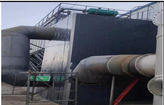
图 4-12 设备箱体隔音
