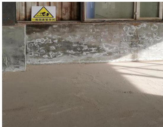
图 3-10 厂房内一般固废暂存区
