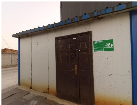
图 3-9 厂区内一般固废暂存间
