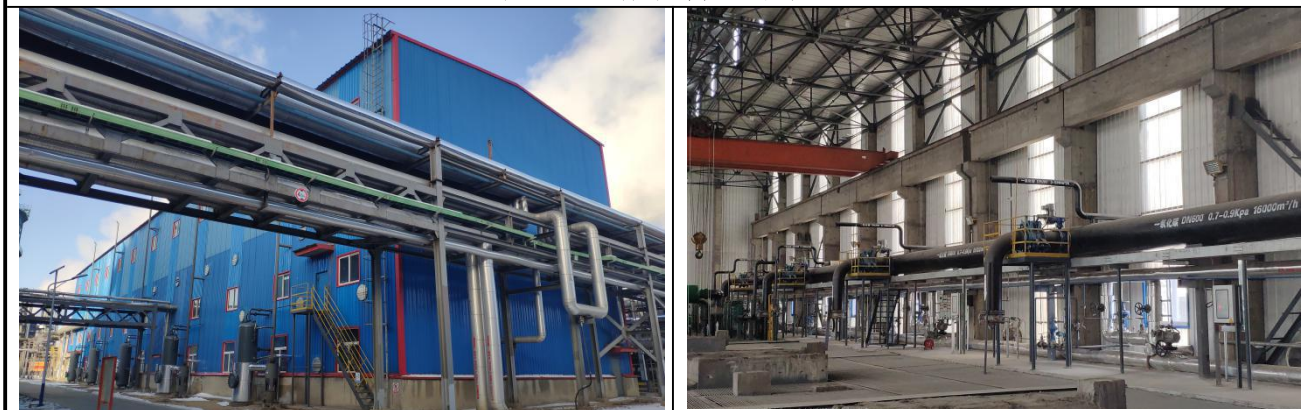
图 3-12 尾气压缩系统
