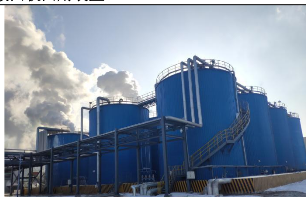
图 3-9 储罐区及围堰
