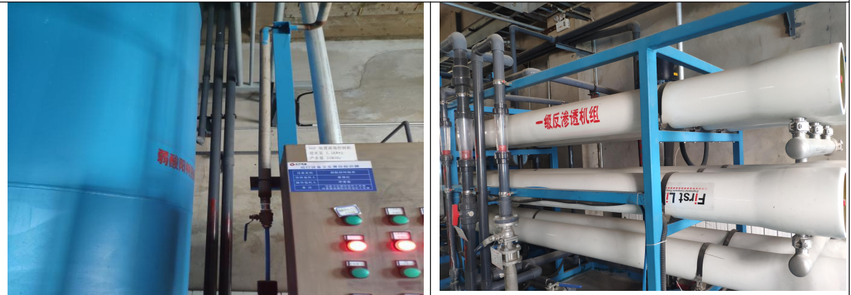
图 3-6 弱酸软化树脂塔+一级反渗透单元
