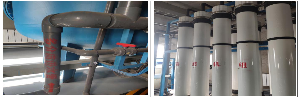
图 3-5 多介质过滤器+外压式超滤单元
