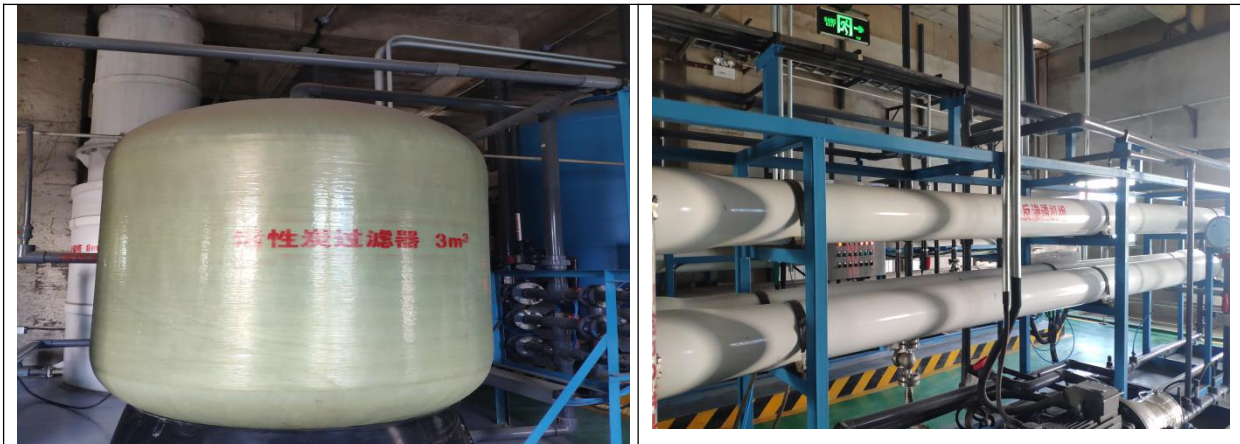
图 3-10 活性炭过滤器+二级反渗透单元
