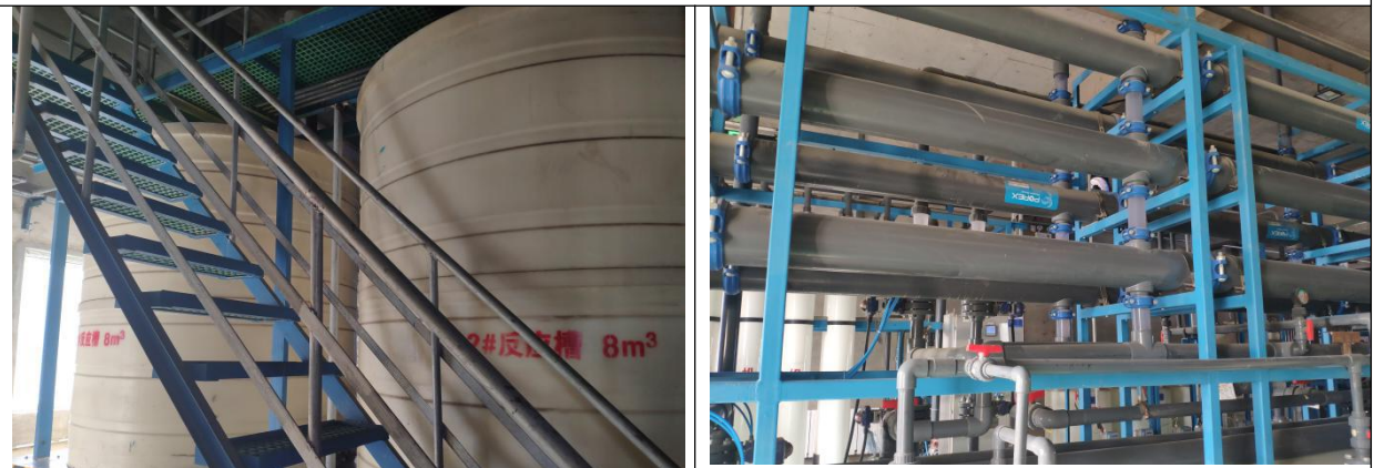
图 3-7 除硬除硅反应池+管式微滤膜单元
