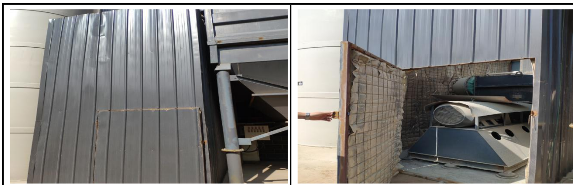
图 4-12 喷淋脱氟除尘电机隔音减振设施
