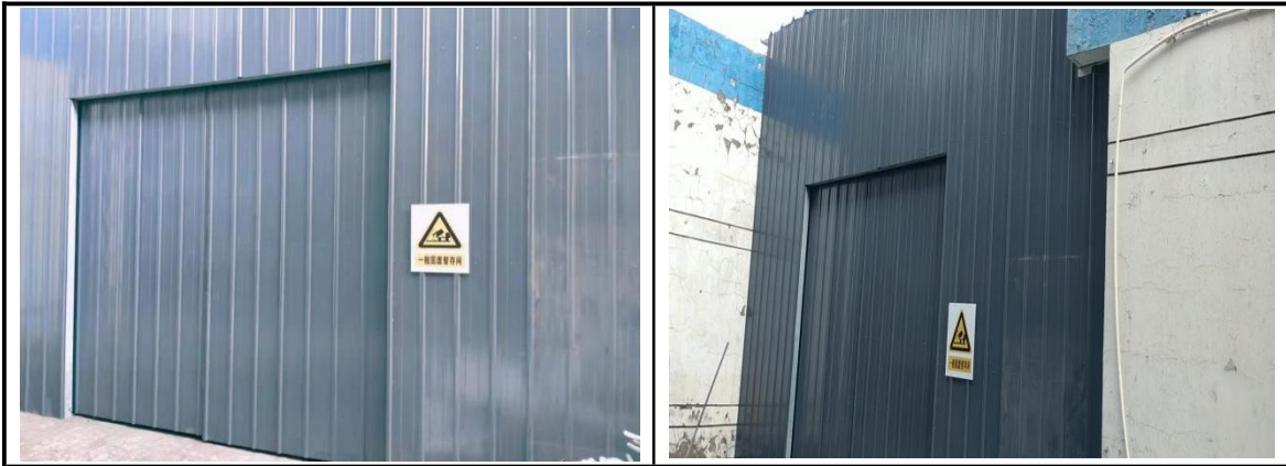
4-14 一般固体废物暂存间
