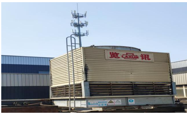
图 4-5 循环水凉水塔
