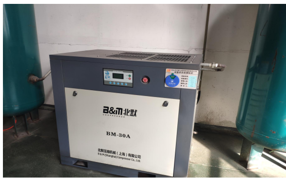
图 4-9 空压机设备箱体隔音
