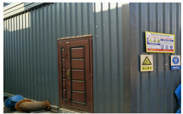
图 4-10 循环泵房厂房隔音
