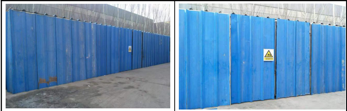
图 4-11 一般固废暂存间
