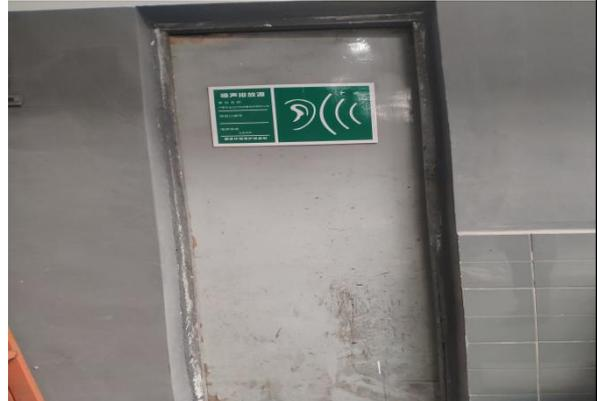
图 3-4 空压机密闭隔音室
