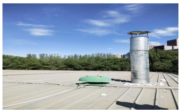
图 3-7 1#喷漆室活性炭吸附废气治理装置及 15m 高排气筒
