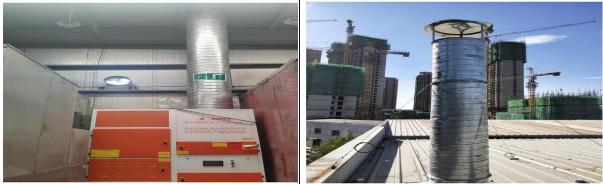
图 3-8 2#喷漆室 VOC<sub>s</sub> 废气治理装置及 15m 高排气筒
