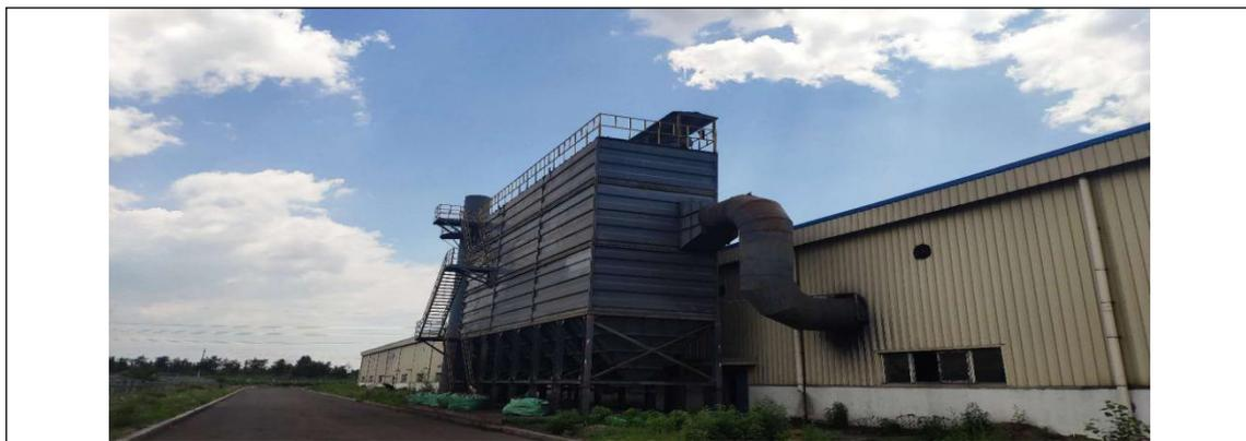
图 4-3 布袋除尘器+15m 高排气筒（内径 1.3m）
