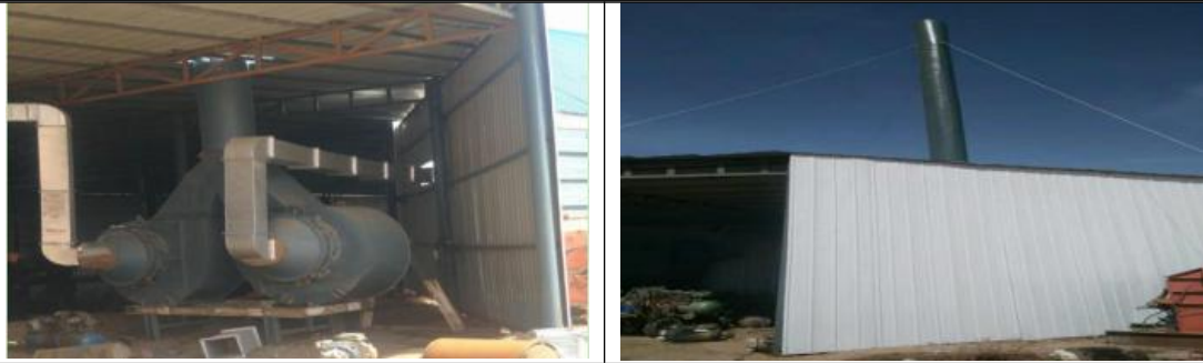
图 3-8 15m 高排气筒（内径 0.4m）
