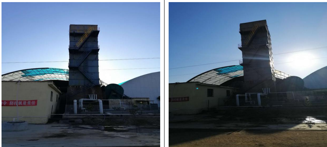
图 3-9 双碱法脱硫除尘设施（高度 18m；出口内径 4×7m；入口内径 1.6×2.2m）
