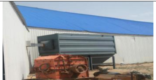
图 3-7 脉冲式布袋除尘器
