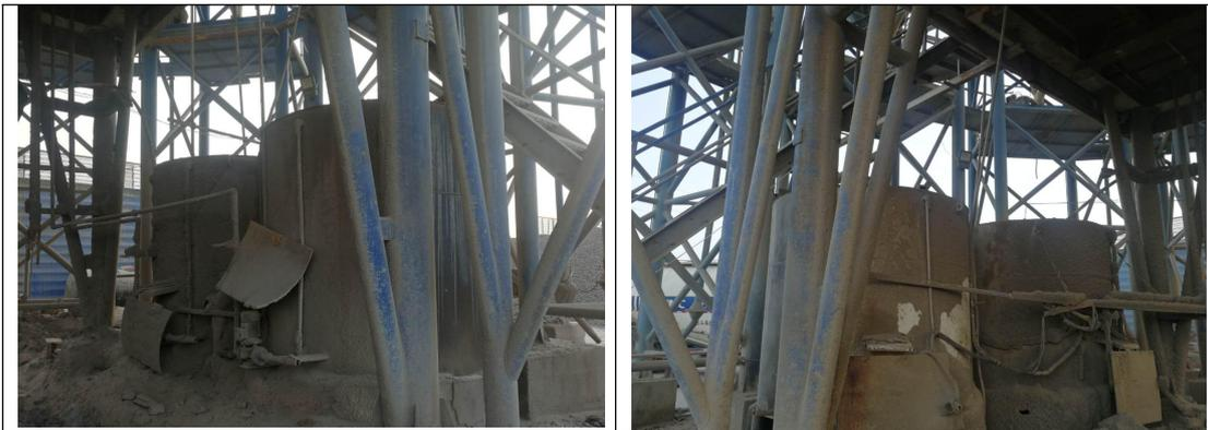
图 2-5 项目外加剂储存罐
